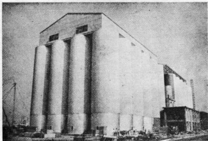
高雄港新建大型散裝穀倉
